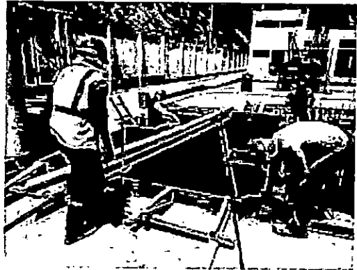
Fotografía N°08: vaciado de vereda en patio de maniobra.
